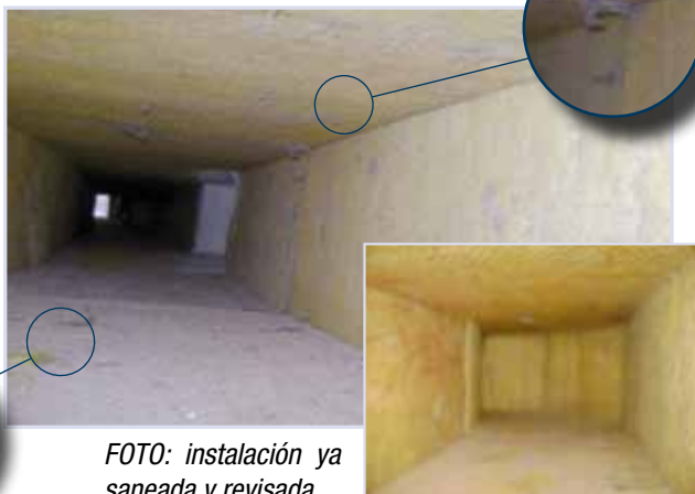
FOTO: instalación contaminada y en mal estado.
