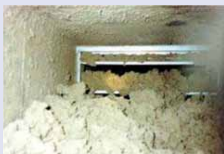
Foto 1: Conducto cepillado, soplado y desinfectado.
